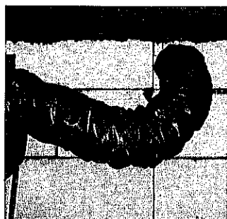
Korrekt montering, svag böj.
